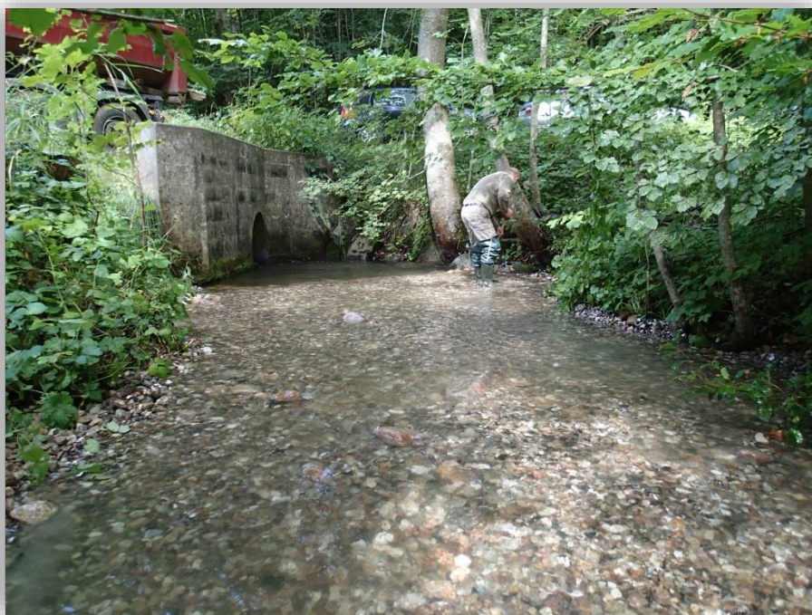
Grusudlægning i mindre vandløb
