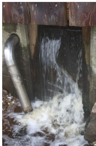
Figur 1a. Her ses ålefælden nedstrøms. Det blanke rør, som er fyldt med enkamat fører op til ålefælden, og vandet fra bækken ryger ud over stigboret. Stigboret er ikke 100 % tæt hverken i sidderne eller i bunden.
