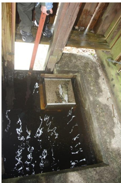
Figur 1. Ålefælden ses sidde i det ene hjørne af det cementbassin som alt vandet fra Hellebækken løber igennem. Øverst i billedet ses stigboret, som holder vandet tilbage.
