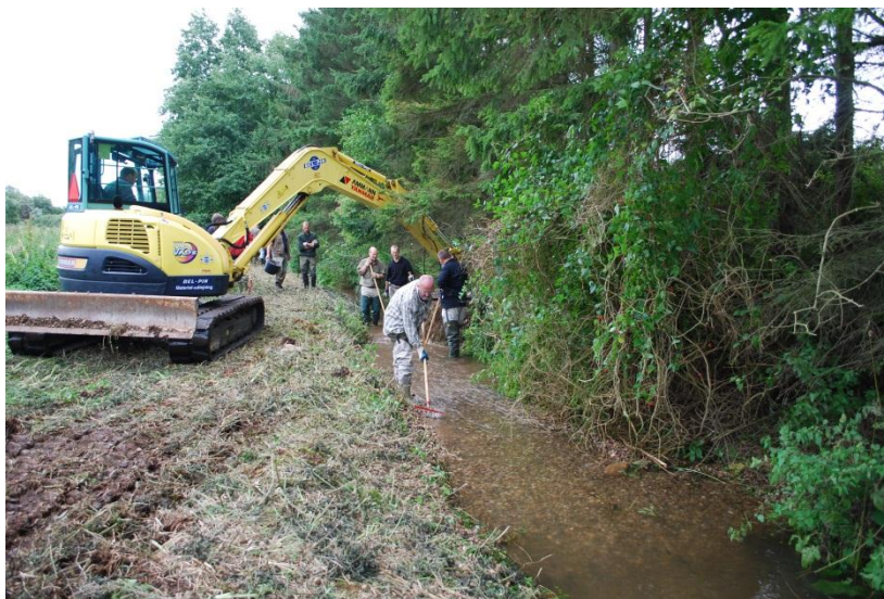
Grusudlægning i mindre vandløb
